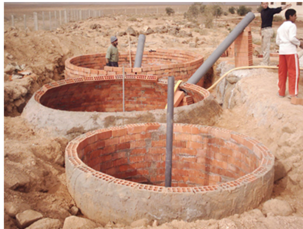
مراحل تنفيذ وحدة إنتاج الغاز الحيوي.
