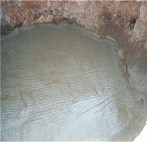
الشكل (3) صب قاعدة المخمر بعد تسويتها ورسفها بالبيتون المسلح.
