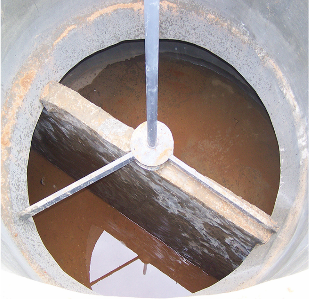
الشكل(8) بناء الجدار الأوسط.
